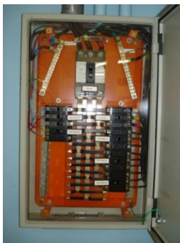
Figura 1 – Modelo do quadro de distribuição com tampa de acrílico.
